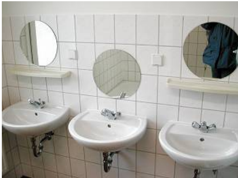
Teilansicht Waschraum, der mittlere Platz ist behindertengerecht
